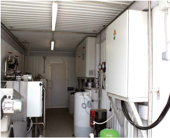
Средства контроля и управления первой конструкции СКВО
