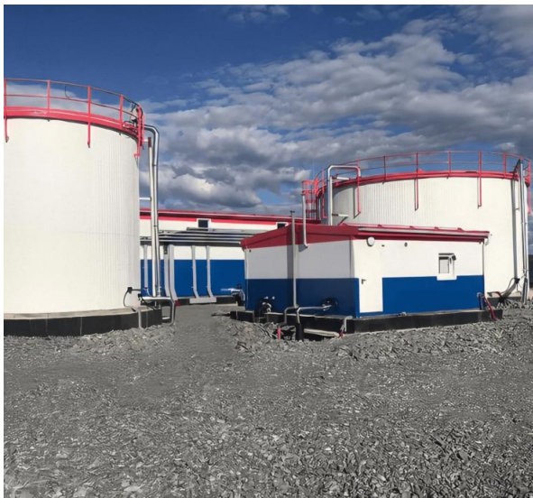
Эксплуатация Центра строительства крупнотоннажных морских сооружений (ЦСКМС) в п. Белокаменка Мурманской области
