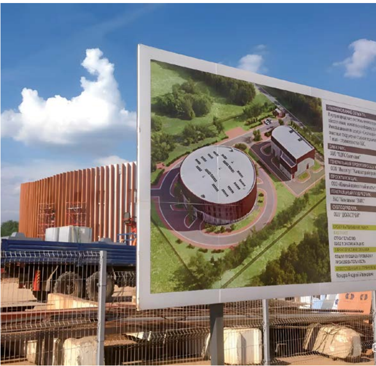
Станция очистки сточных вод Мегapolis
