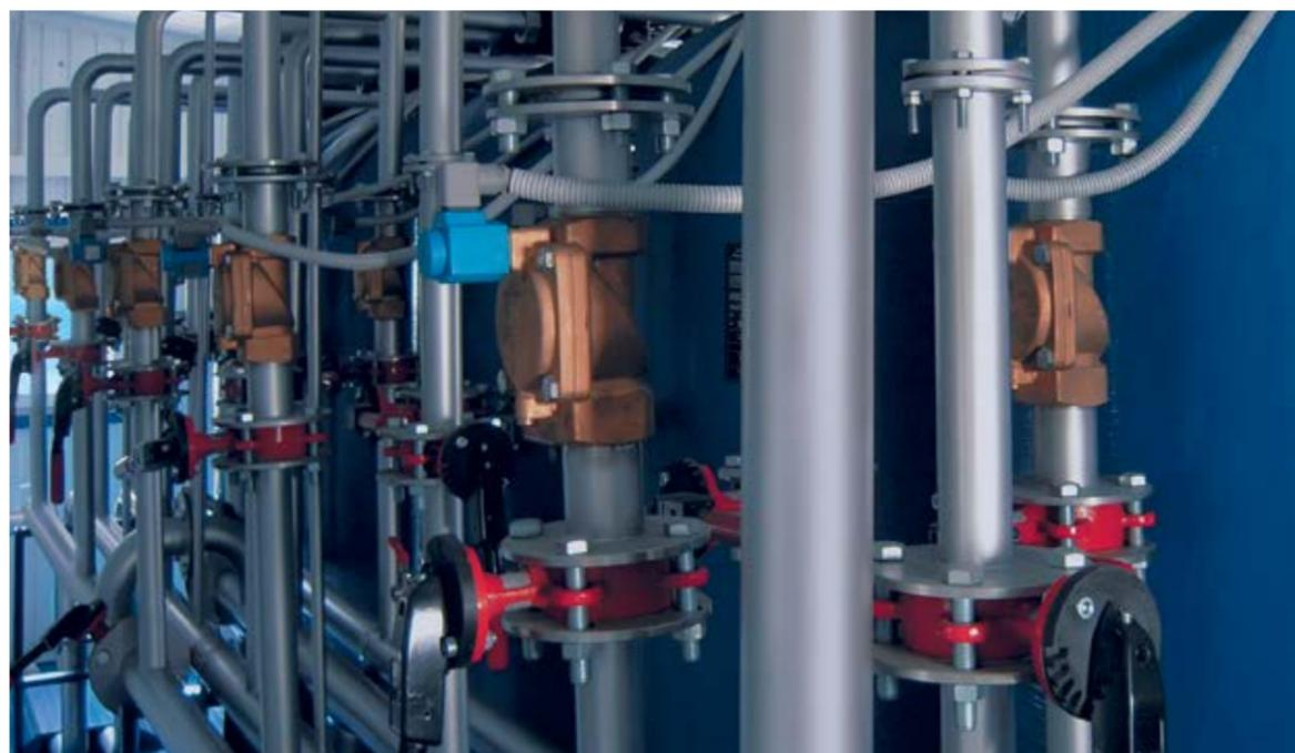
▲ Все трубопроводы изготовлены из нержавеющей стали
